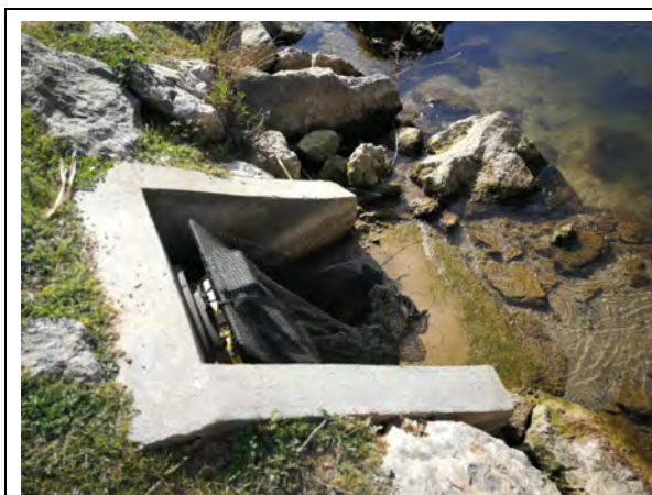
Photo d'un dispositif récupération des macrodéchets en sortie d'exutoires pluviales avant rejet dans l'eau (Source : Photo Commune de Mandelieu La Napoule, Exutoire existant sur Siagne)
